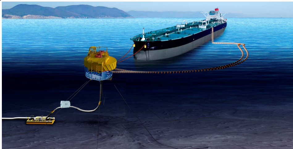
Рис. 1. Общий вид плавучего морского однотоочного причала
