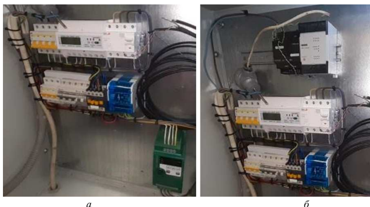
Рис. 14. Монтаж электрической части: а — УЗО и нулевой DIN-рейки; б — блока питания
