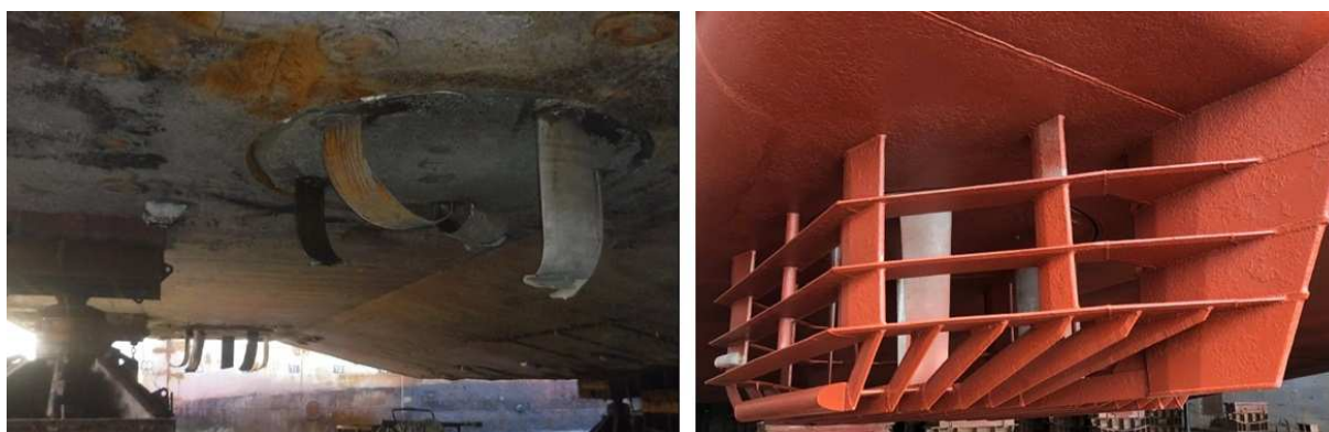
Рис. 10. Повреждение крыльчатого движителя на плавкране (слева); защита крыльчатых движителей на плавкране (справа) 5
