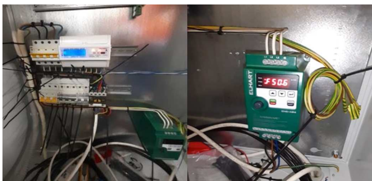
Рис. 13. Проверка работоспособности системы после электромонтажа
