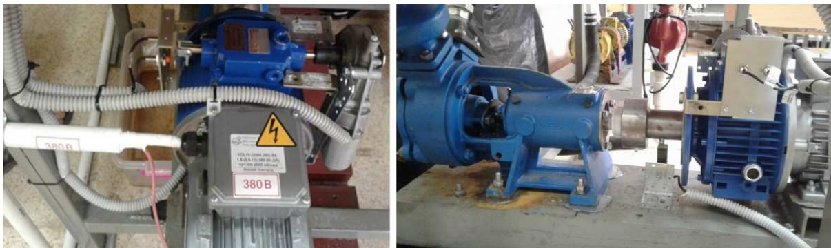
Рис. 12. Насос системы охлаждения с вариатором
