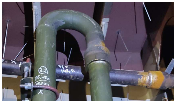
Рис. 4 Сварные муфтовые соединения, выполненные на судне (фото автора)
